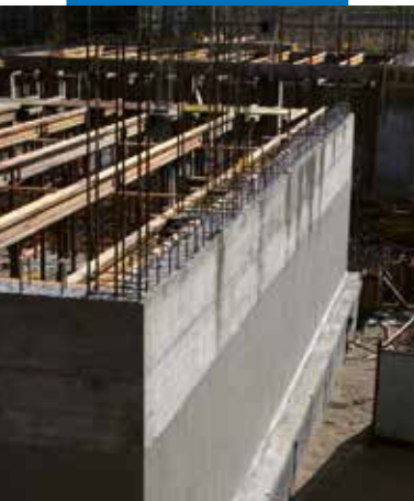
Vodotesné ošetrenie oporných stien použitím Mapelastic Foundation
