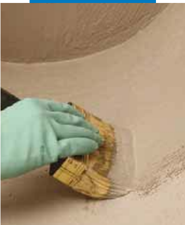
Hydroizolácia terasy štetcom
