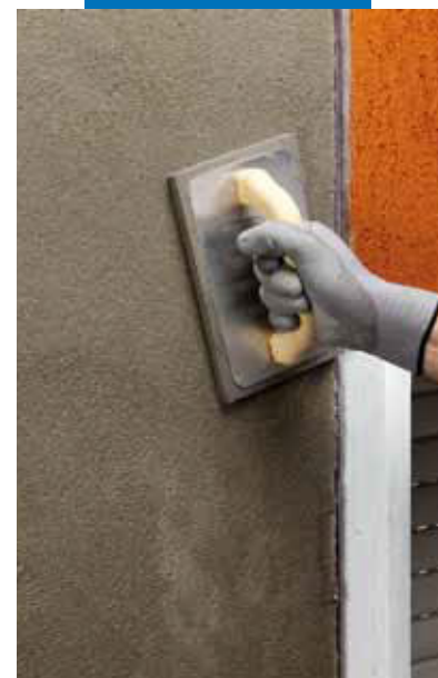
Vyhľadanie povrchu Planitop 217
