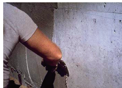
Stierka PCI Barraseal ® 2K Objekt sa môže nanášať špachtľou, štetkou, valčekom alebo nástrakom.
